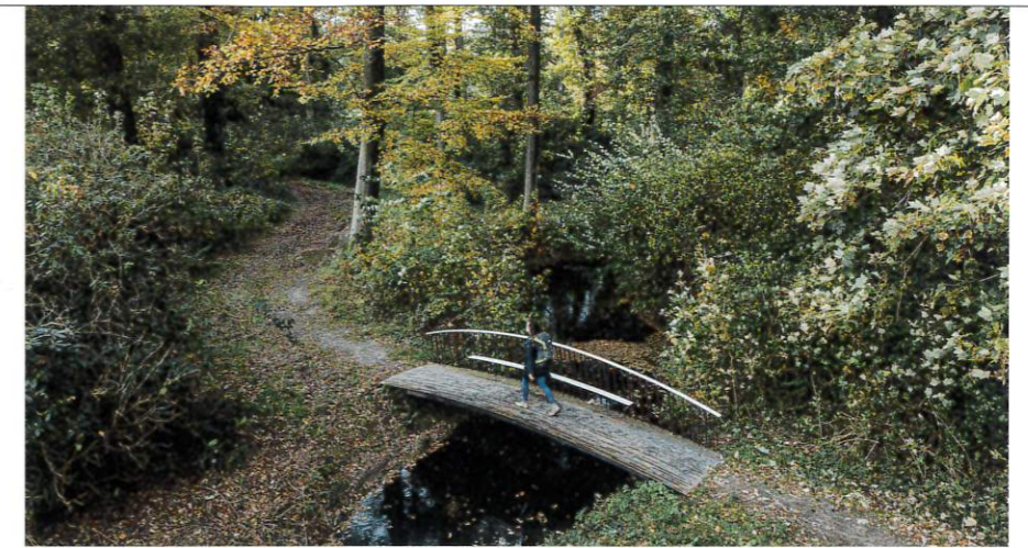
De zeven bruggen variëren in lengte van 5 tot 12 m, afhankelijk van de locatie. Het zijn zogenaamde toogbruggen; het stalen brugdek is opgespannen tussen de oevers. Ze hebben geen fundering nodig in de vorm van bijvoorbeeld palen. De watergang wordt daardoor niet verstoord, zodoende gaan de bruggen nog meer op in het landschap.
